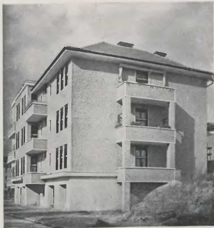
Wohnhaus Oranienstraße. Arch. Prot. Adolf Rading
