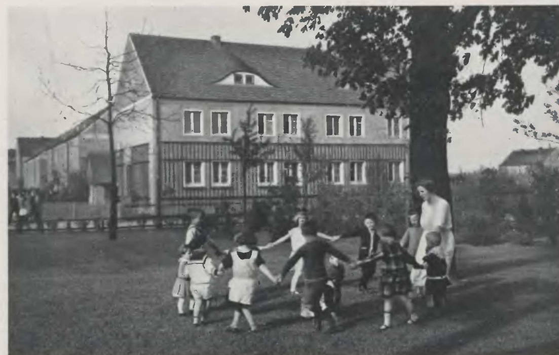
Siedlung Eichborngarten, Fliederplatz. Arch. B.D.A. P. Heim
