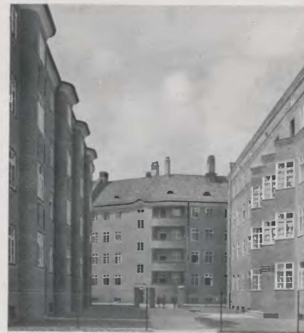
Wohnhäuser Düppelstraße. Arch. B.D.A. Theo Effenberger
