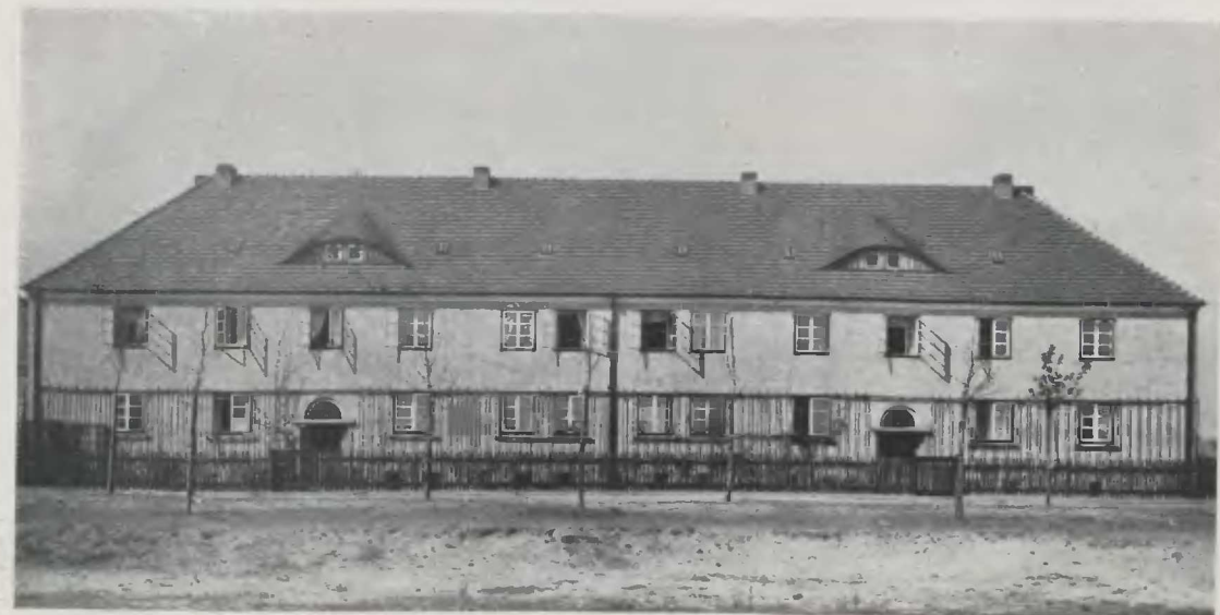
Siedlung Zimpel, Wohnhaus am Meisenweg. Arch. B.D.A. P. Heim
