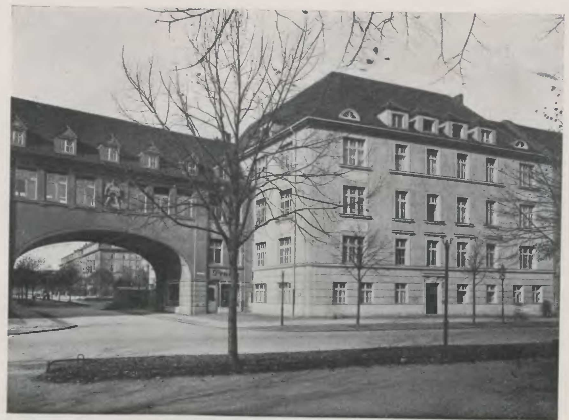
Wohnhaus Kaiser-Wilhelm-Straße. Arch. B. D. A. Gaze u. Böttcher
