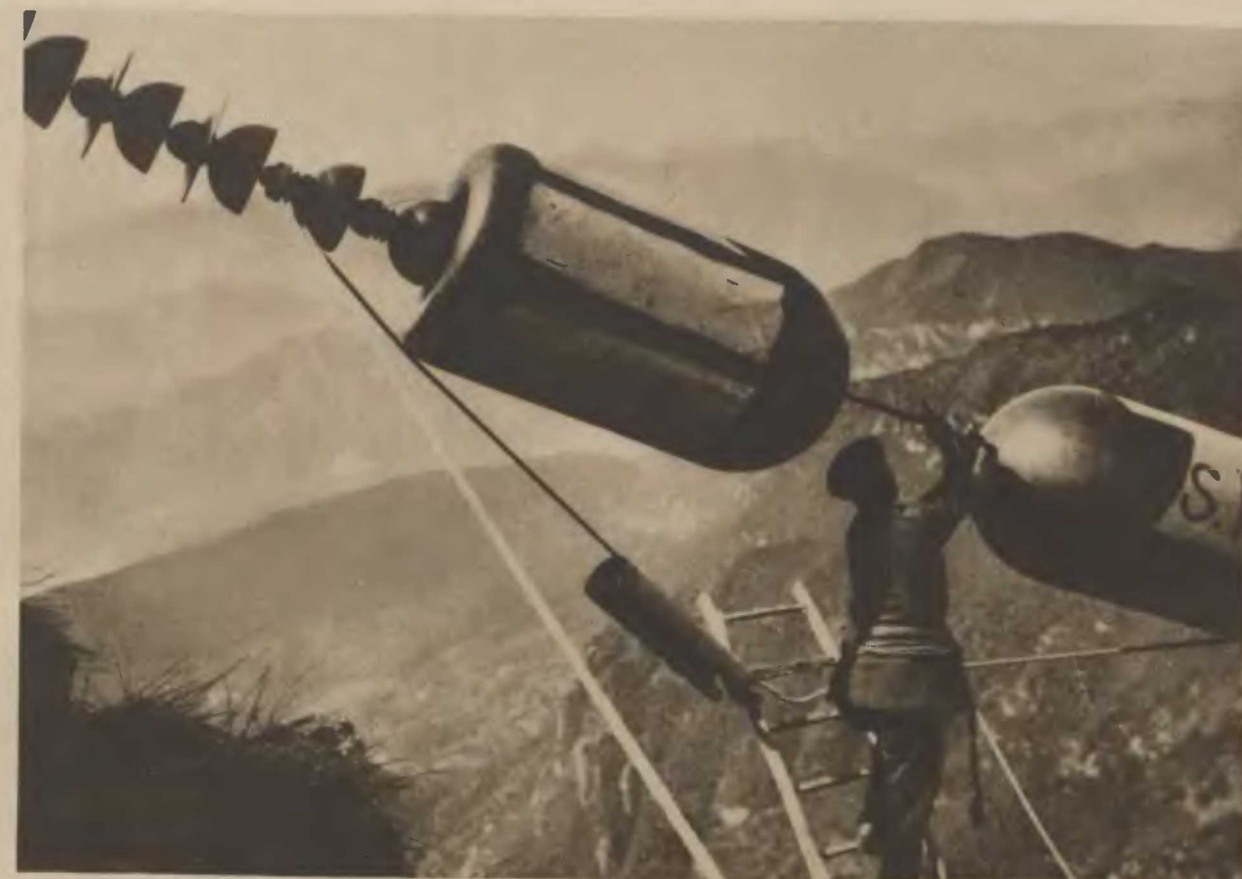
Bei der Montage der riesigen Isolatorenfetten und Sprühschäufelkörper
