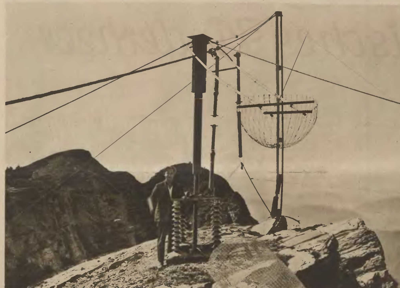
Hochspannungsfäden und Funkenstrecke auf der Spitze des Monte Generoso
