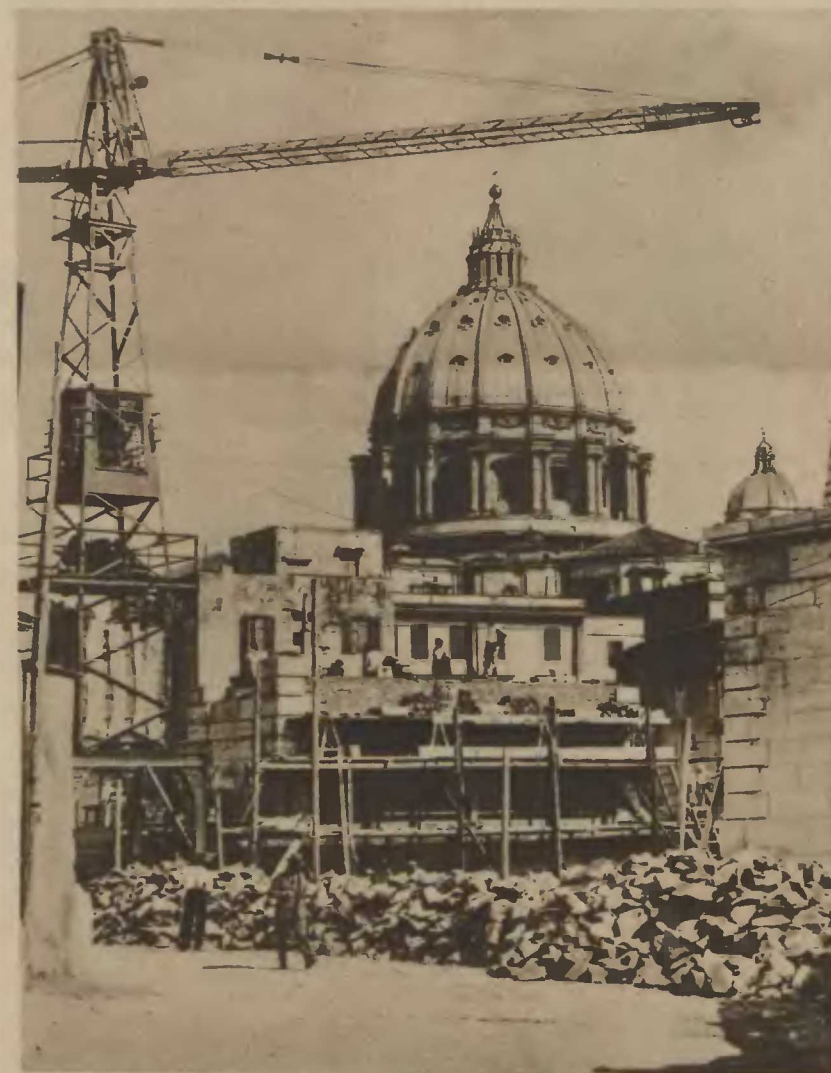
Der Vatikan wird durch eine Eisenbahn mit der Außenwelt verbunden. Durchbruch durch die Mauer des Vatikans Presse-Photo
