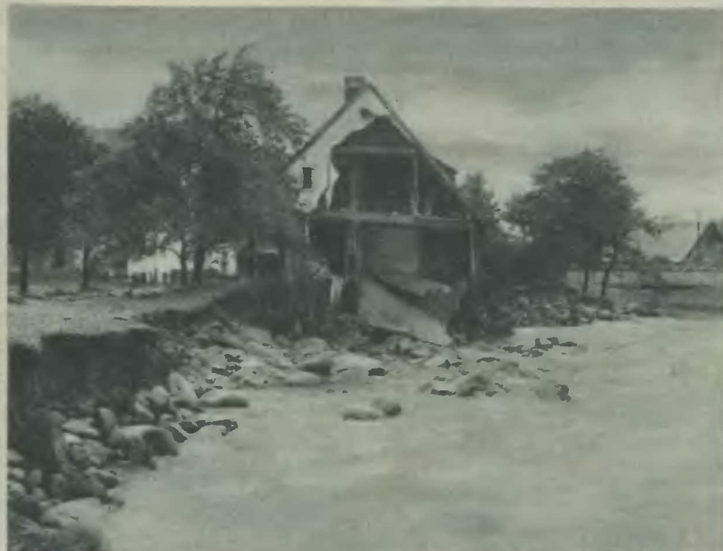
Im Niederdorfe zerstörtes Haus des Maurers Köfel Phot. W. Goetsch, Hain im Riesengebirge
