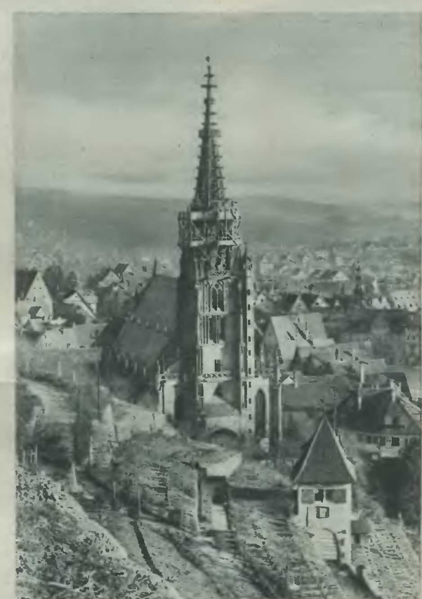
Die Frauenkirche in Gillingen a. A. A. A., ein Kleinod deutscher Spätgotik aus dem 14. Jahrhundert, eines der wertvollsten Denkmale der deutschen gotischen Baukunst, hat unter den Witterungseinflüssen, denen das artgeliebte Steinwerk Jahrhunderte lang ausgesetzt war, so gelitten, daß allmählich ein Stück um das andere abgebrochen ist. — Der Kirschturm, an dem jetzt die Instandsetzungsarbeiten vorgenommen werden. Unten: Der 86-jährige Feldzeugmeister Merkel, der einzige noch Überlebende der „Batterie der Toten“ auf österreichischer Seite nach der Schlacht bei Königgrätz, dem Hindenburg zum 60. Jahrestage dieser Schlacht, als dem „einstigen ritterlichen Gegner“, einen Gruß sandte. Brandenburg
