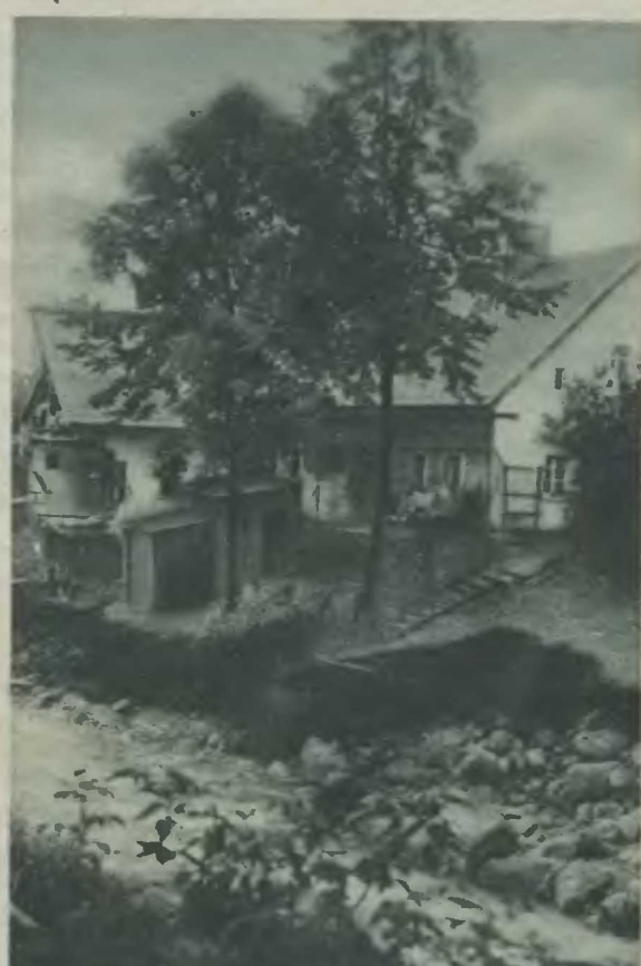
Im Mitteldorfe weggerissene Gärten und beschädigtes Hinterhaus von Elsner Phot. W. Goetsch, Hain im Riesengebirge
