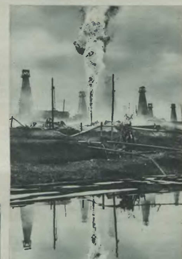
Seit dem 30. Juni brannte tagelang in Campina (Rumänien) die Sonde 41 der größten rumänischen Petroleumgesellschaft Steaua Romana, wobei täglich 1000 Waggons Rohöl im Werte von 1 Million Lei verbrannten. — Solche Brände sind unbeschreiblich, die ganze Sonde muß ausbrennen. Sonderaufnahme für unsere Beilage von Dr. Merkel
