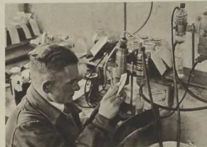
Untersuchung der Ölverdünnung im Laboratorium
