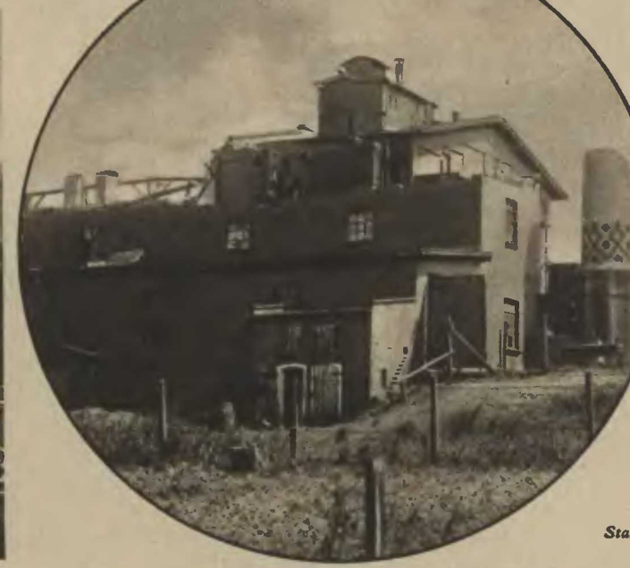
Die Brennerei in Schützenhof St. Dels nach dem Sturm.
