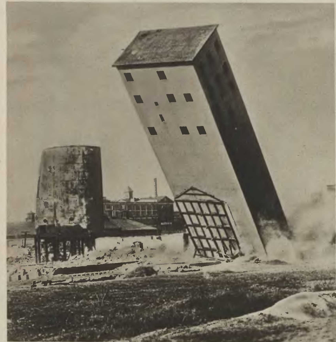
Das Alte stürzt. Explosion eines alten Stahlelevators in der Nähe von Baltimore. Dem Photographen ist es gelingen, den Augenblick des Zusammenbruchs auf die Platte zu bannen
