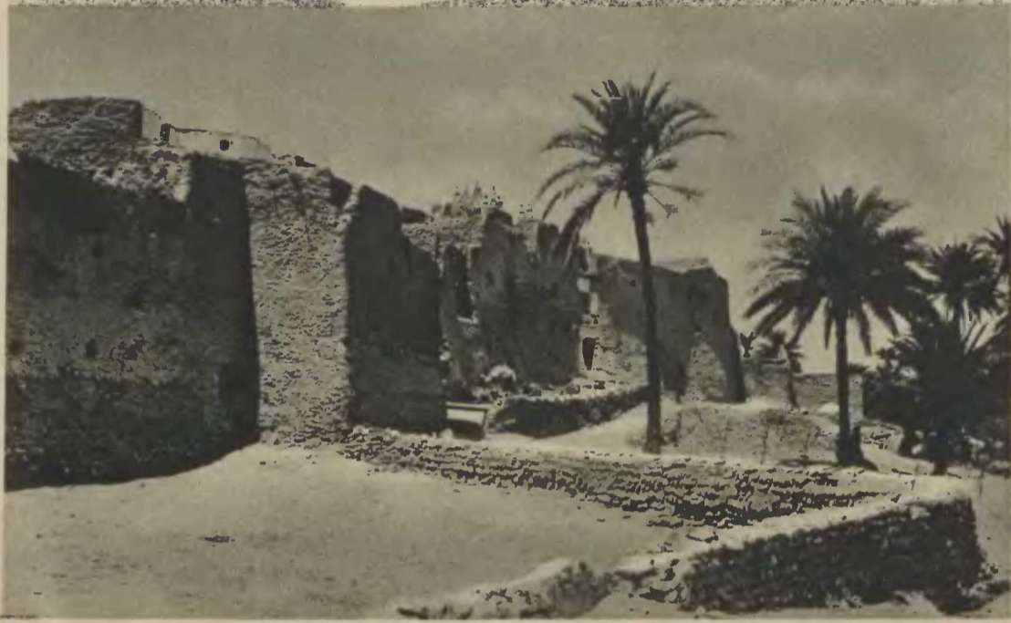
Die Stadtmauern von Derz bei Gadames
