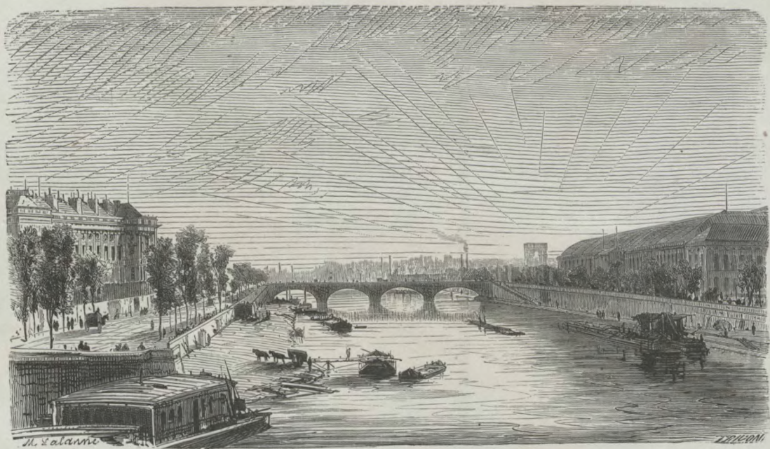
VUE PRISE DU PONT DE LA CONCORDE
