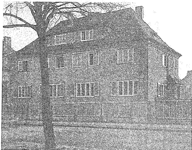
Haus Arch. W. Matthes, Leipzig. Straßensicht
