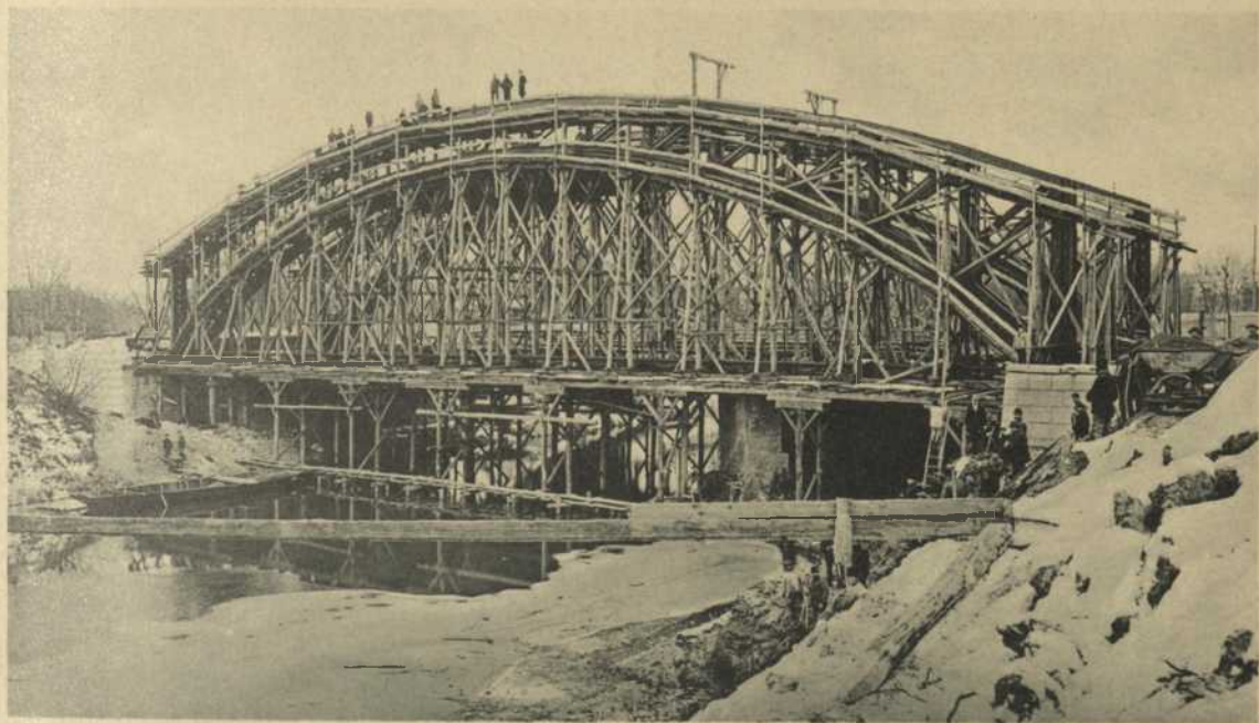
Passbrücke Aufstellungsgerüst für die eisernen Bogenträger.
