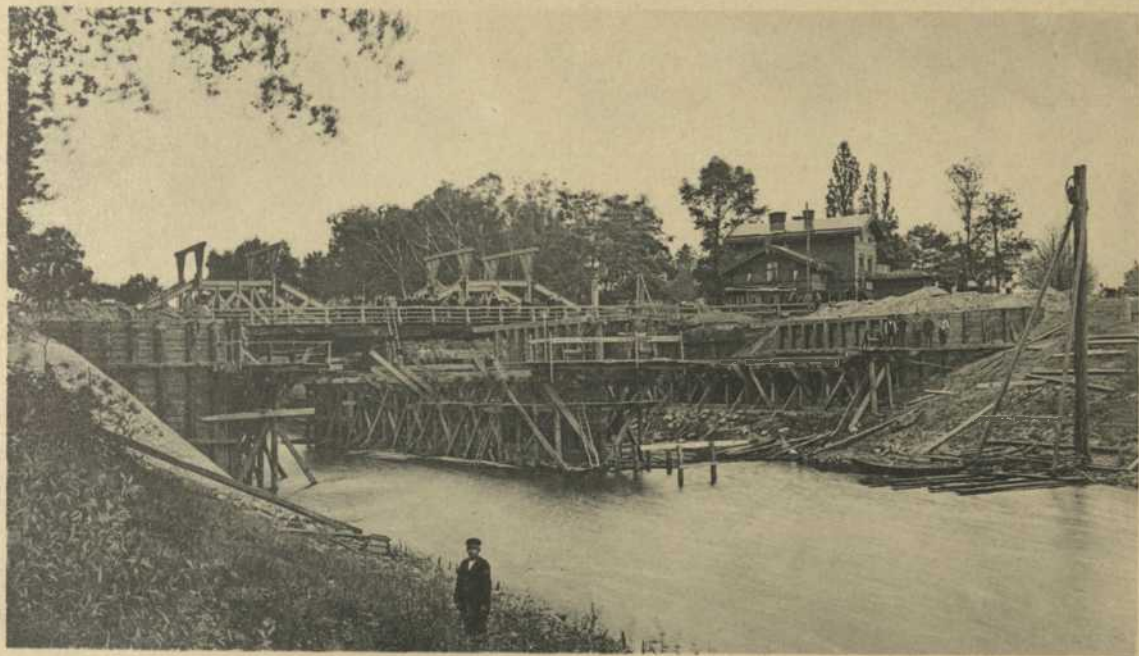
Alte Passbrücke mit Verschiebungsgerüst.
