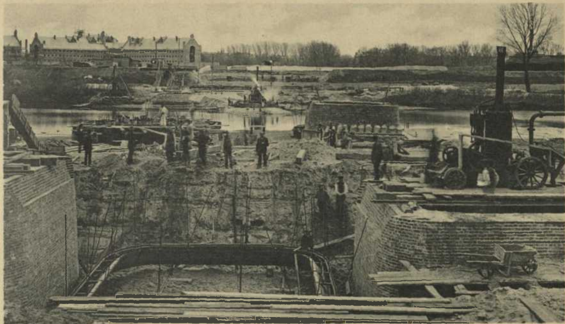
Oswitzer Brücke Gründungsarbeiten.
