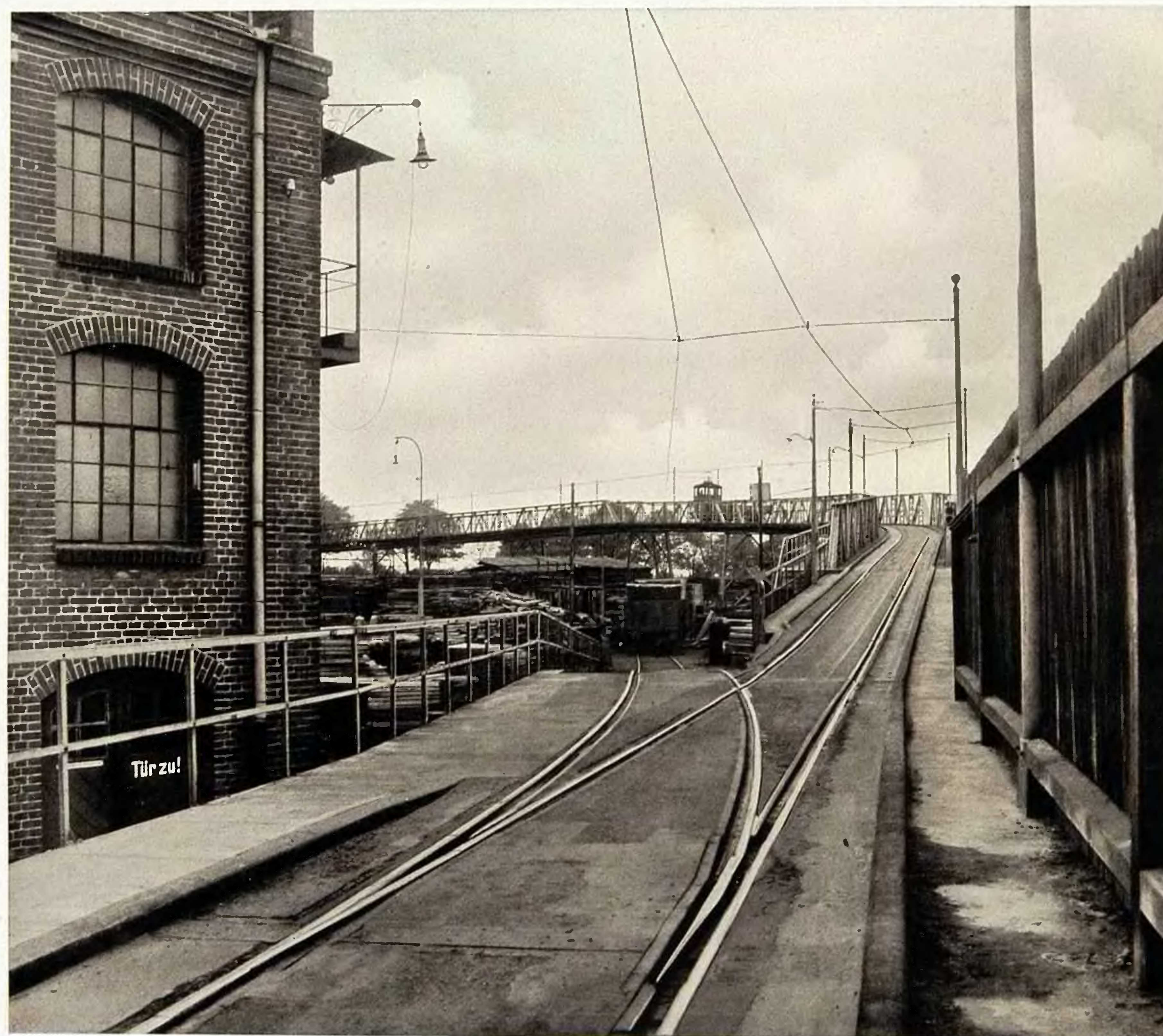
ELEKTRISCHE BAHNSTRECKE AUF DER VERBINDUNGSBRÜCKE ZWISCHEN DEN WERKEN »MOCHBERN« UND »POPELWITZ«
