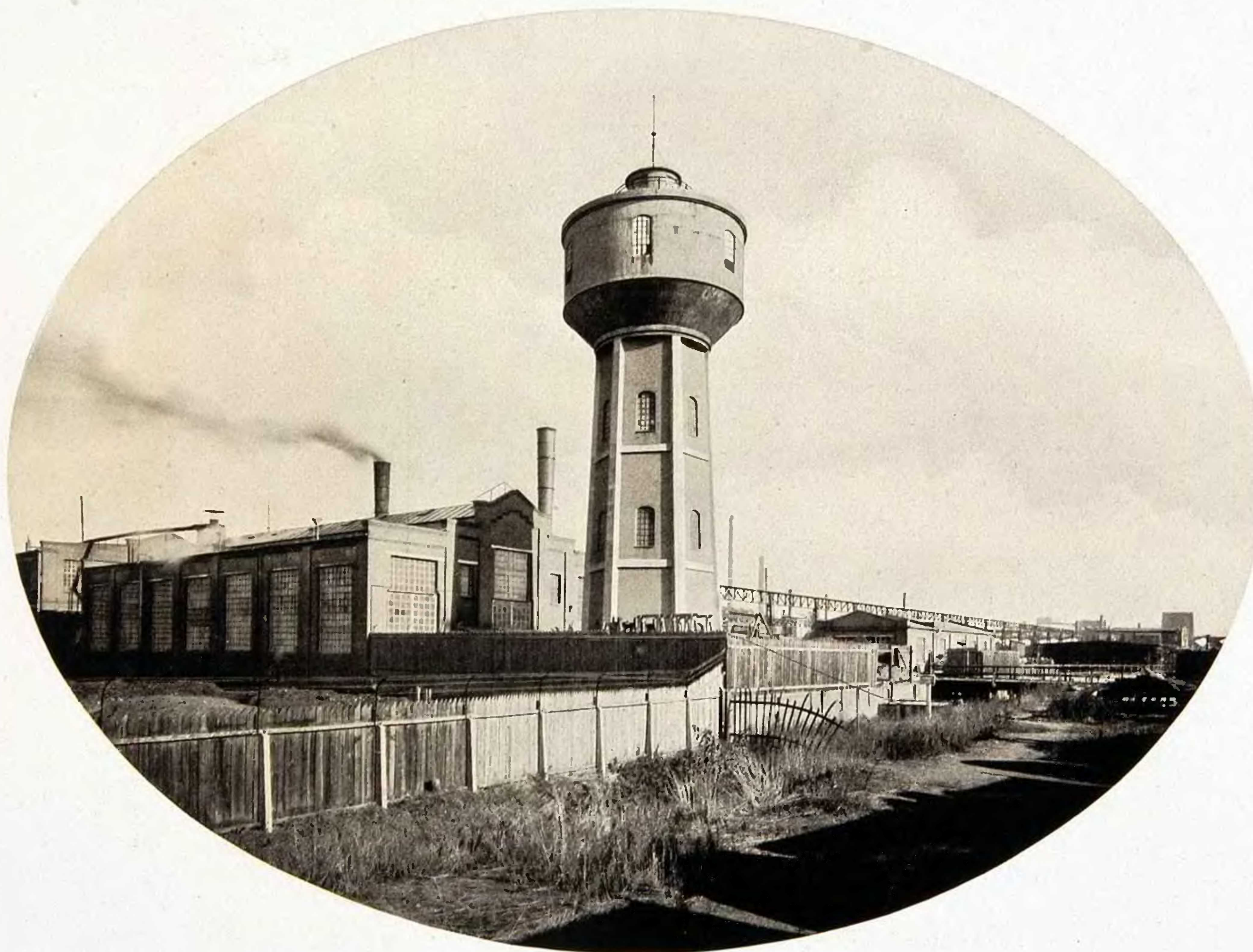
SÜDWESTSPITZE DES WERKES MOCHBERN AM PFEFFERGRABEN MIT WASSERTURM UND KESSELHAUS
