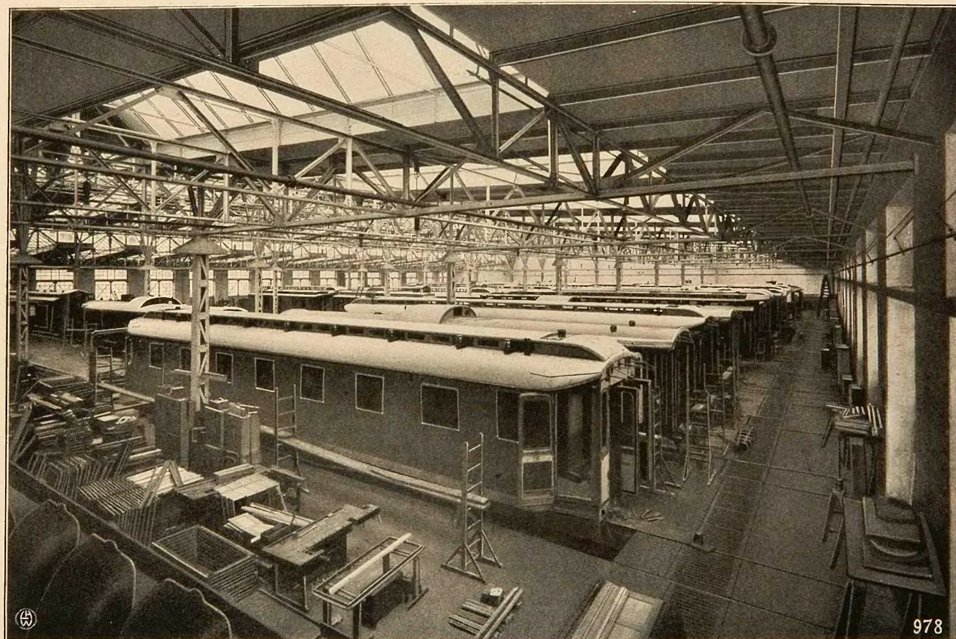
Eine der Werkstätten in Halle I für Eisenbahnwagenbau
