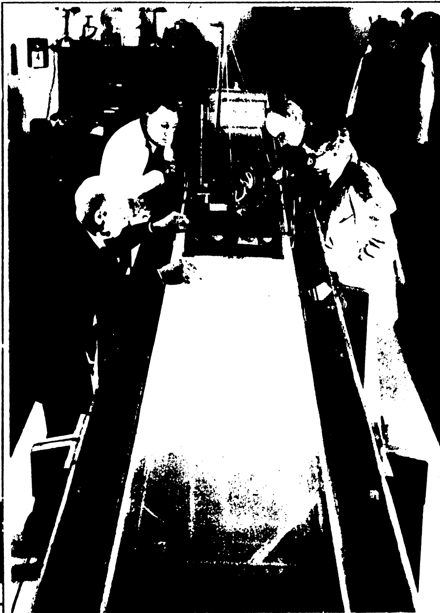
Versuchswagen, unter ihm der Propeller im Wassertank Durch den auf dem Wagen befindlichen Elektromotor wird der Propeller in rasche Umdrehung versetzt, wodurch der Wagen mit großer Geschwindigkeit vorwärts getrieben wird
