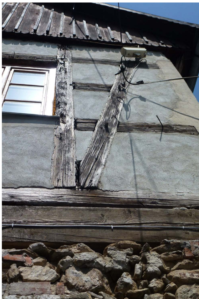
Fot. 11. Fragment elewacji południowej dawnego magła wodnego – widoczna konstrukcja z kamienia polnego w parterze budynku i konstrukcja ryglowa na piętrze, czerwiec 2014
