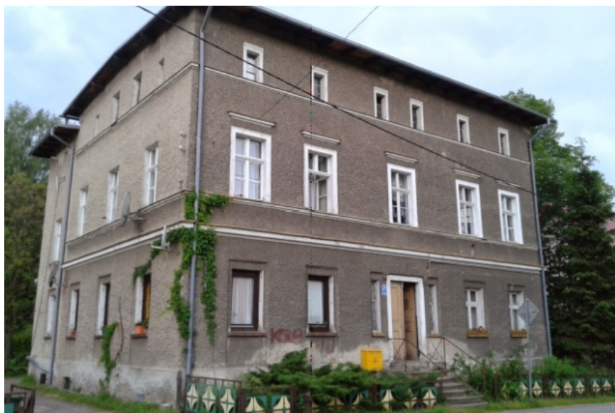
Fot. 37. Budynek dawnej szkoły katolickiej, ulica Wyszyńskiego 17
