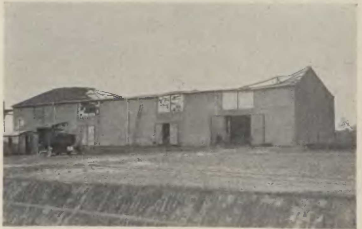
Gesamtansicht des Brandobjektes. Lichtbild (5) Archiv Schles. Feuerwehr-Vlg. Zuckerfabrik Oberglogau. Brand vom 2. 11. 1936
