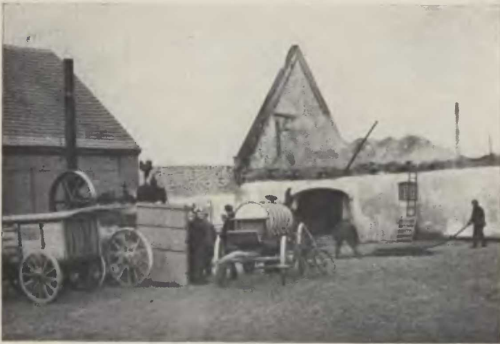
(Bild 1) Schilfgedecktes Stallgebäude. Brandstelle I
