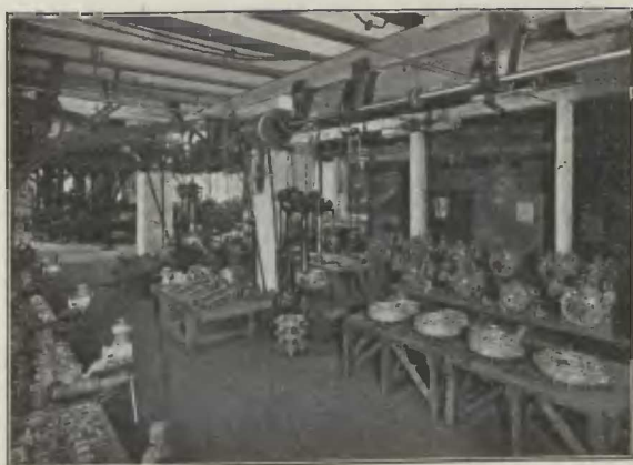
Halle für den Pumpenbau
