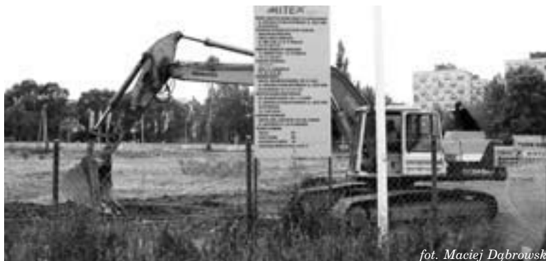
Rozpoczęła się budowa nowego gmachu Biblioteki UWr.
