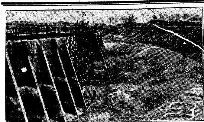
Berlin czyni energiczne przygotowania do olimpiady, jaka odbędzie się w 1936 r. w stolicy Rzeszy. Na ilustracji widzimy potężną ścianę betonową, o którą oparte będą trybuny stadionu, obliczone na 100 tysięcy miejsc.
