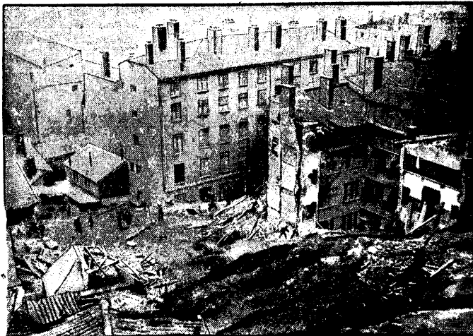
która uległa najsilniejszemu zniszczeniu skutkiem obsunięcia się stoku wzgórza. (Oryginalne zdjęcie.)
