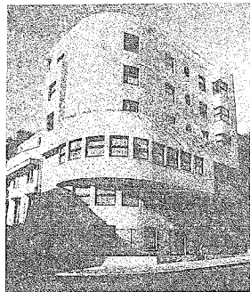
Amerikanisches Studentenheim in Paris. Arch.: Pol-Abraham. Der Bau als einheitliche Masse ohne Angabe struktureller Gliederung, auch der Mauer orientierter Längsbau. In Wirklichkeit aber ein Eisenbetonstützenbau. Prinzipielle Vermeidung schützender Gesimse und Ableitung des Regenwassers zum Teil durch das Innere des Hauses.
